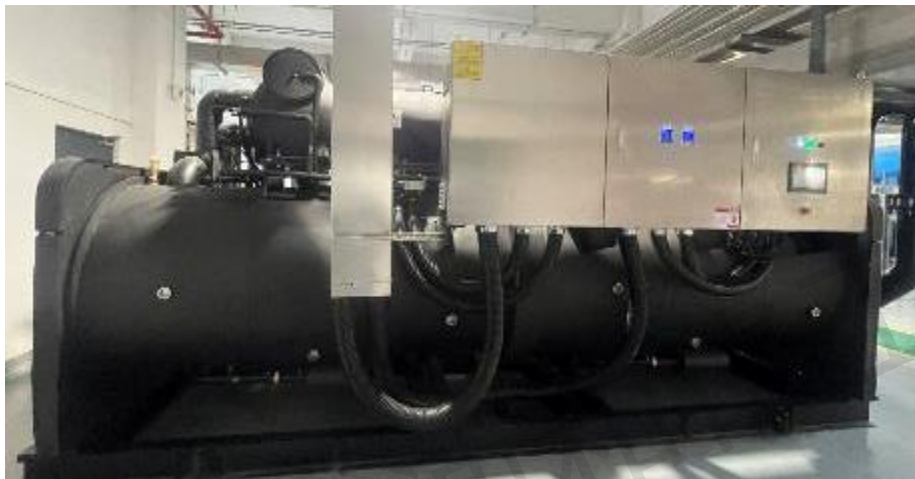
上海虹桥污水处理厂
